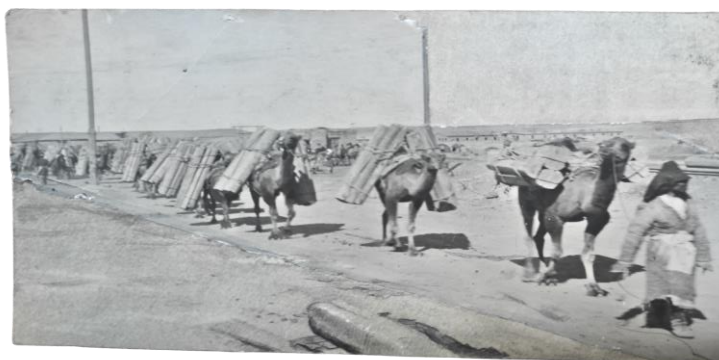
Рис.2. ФПК 12734 Фото английского фотографа «Перевозка шпал на верблюдах на строительстве узко-колейной железной дороги Джусалы-Карсакапай».
