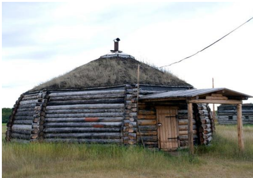
5-сурет. Саха, Тывадағы көп бұрышты тұрғын үй (реконструкция) [Figure 5. Multi-corner housing in Sakha, Tyva (reconstruction)]
